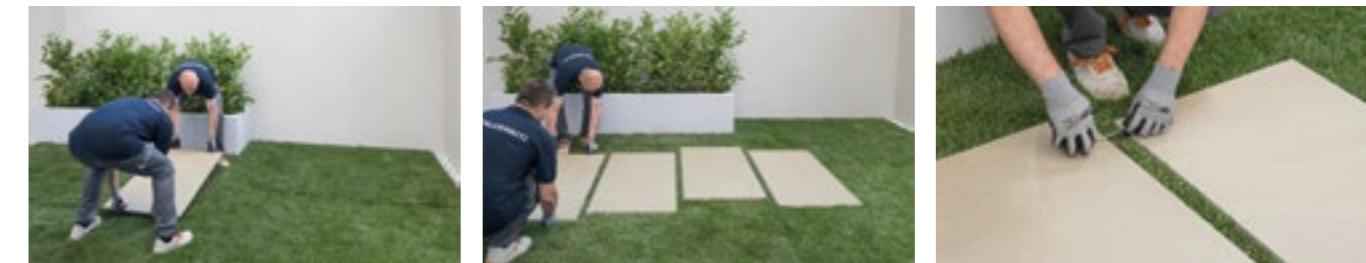
Posizionare le lastre a secco sull'erba e verificare che la distanza tra l'una e l'altra sia regolare per tutta la superficie di posa.
