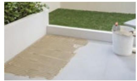
Pulire la superficie esistente e verificare che il massetto sia eseguito ad opera d'arte: pianare, asciutto, stagionato. Stendere la colla adesiva in maniera omogenea sulla superficie.
