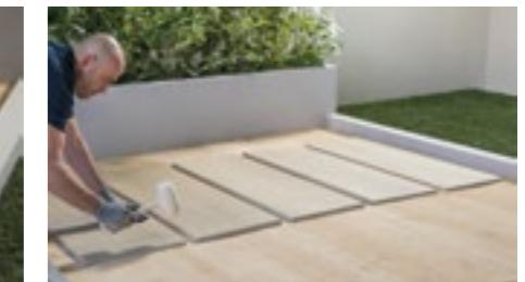
Posizionare le lastre a secco sulla sabbia e verificare che la distanza tra l'una e l'altra sia regolare per tutta la superficie di posa. Battere leggermente con la mazzetta di gomma per stabilizzare la posa.
