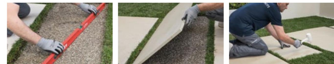
Dopo aver verificato la planarità del fondo realizzato, posizionare le lastre e battere leggermente con la mazzetta di gomma per stabilizzare la posa ed eliminare eventuali irregolarità.
