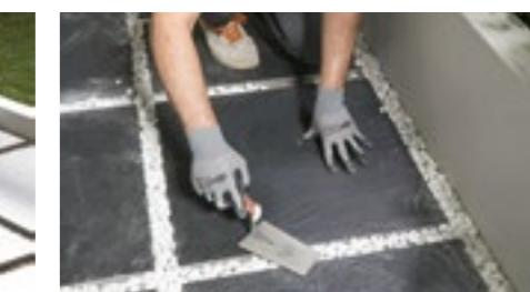
Verificare la planarità della posa ottenuta. Aggiungere ghiaia tra le fughe per livellare la pavimentazione. E' possibile utilizzare anche ghiaia decorativa di diametro superiore rispetto a quella posata sul il sottofondo.
