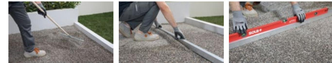
Preparare sul sottofondo esistente uno strato di ghiaia (diam. 3/6 mm) di almeno 5 cm di spessore. Livellare la superficie con la staggia e verificarne la planarità.
