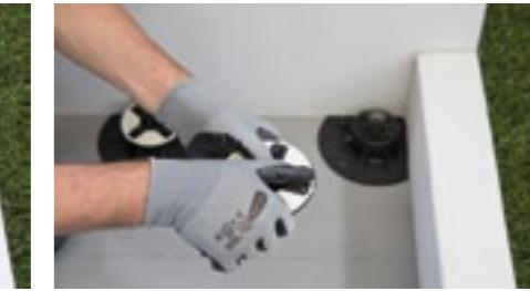
Pulire la superficie esistente e verificare la planarità del massetto per identificare il giusto supporto da utilizzare. Il massetto deve essere asciutto e stagionato. Preparare i supporti selezionati, tagliando a misura i supporti perimetrali ed eliminando le alette superflue.
