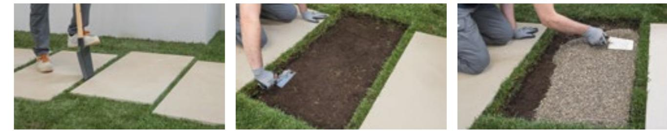
Tracciare la porzione di terreno da asportare e realizzare uno scavo di profondità minima di 5 cm. Creare uno strato di ghiaia (diam. 3/6 mm) di almeno 3 cm.
