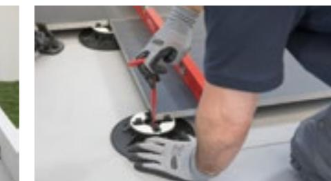
Posizionare a secco le lastre sui supporti. Aggiungere un supporto al centro della lastra, eliminando le alette distanziatrici. Verificare sistematicamente la planarità e regolare le altezze dei supporti con l'apposita chiave di regolazione per compensare eventuali irregolarità del sottostante. Si suggerisce di prevedere idonee ed opportune pendenze al fine di ridurre il rischio di ristagni d'acqua.
