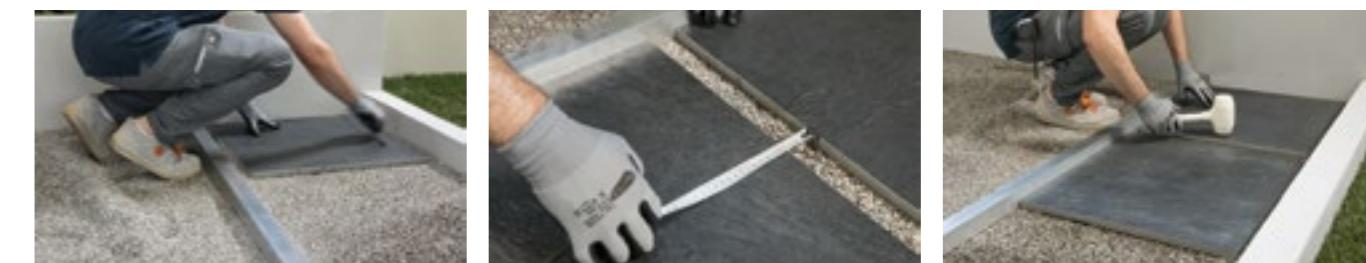
Posizionare le lastre a secco sulla ghiaia e che la distanza tra l'una e l'altra sia regolare per tutta la superficie di posa. Battre leggermente con la mazzetta di gomma per stabilizzare la posa ed eliminare eventuali irregolarità.
