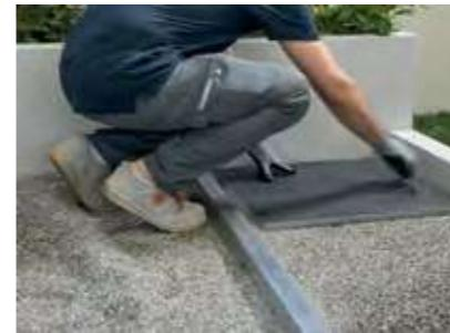
Posizionare le lastre a secco sulla ghiaia e che la distanza tra l'una e l'altra sia regolare per tutta la superficie di posa. Battere leggermente con la mazzetta di gomma per stabilizzare la posa ed eliminare eventuali irregolarità.
