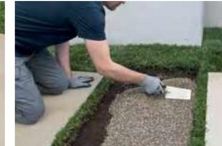
Tracciare la porzione di terreno da asportare e realizzare uno scavo di profondità minima di 5 cm. Creare uno strato di ghiaia (diam. 3/6 mm) di almeno 3 cm.
