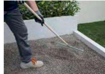
Preparare sul sottofondo esistente uno strato di ghiaia (diam. 3/6 mm) di almeno 5 cm di spessore. Livellare la superficie con la staggia e verificarne la planarità.
