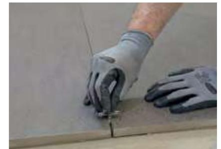
Positionner les dalles et battre légèrement à l'aide d'un maillet en caoutchouc pour chasser l'air et garantir une parfaite adhérence. Placer dans les joints les espaceurs de 4/5 mm.
