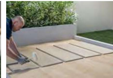
Poser les dalles à sec sur le sable et s'assurer que la distance les séparant est régulière sur toute la surface de pose. Battre légèrement à l'aide d'un maillet en caoutchouc pour stabiliser la pose.
