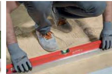
Préparer une couche de sable d'au moins 5 cm d'épaisseur sur le fond existant (chape ou surface de gravier). Niveler la surface à l'aide d'une règle et en vérifier la planéité.
