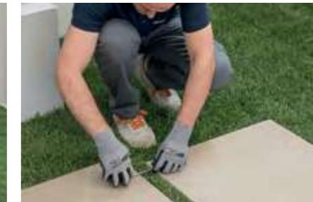
Posizionare le lastre a secco sull'erba e verificare che la distanza tra l'una e l'altra sia regolare per tutta la superficie di posa.
