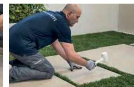
Dopo aver verificato la planarità del fondo realizzato, posizionare le lastre e battere leggermente con la mazzetta di gomma per stabilizzare la posa ed eliminare eventuali irregolarità.
