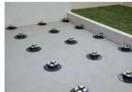
Sur la base du schéma de pose, positionner les supports en commençant par le pourtour. Poser le clip de protection de bord du carreau sur les supports au contact du mur.
