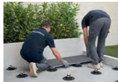
Posizionare a secco le lastre sui supporti. Aggiungere un supporto al centro della lastra, eliminando le alette distanziatrici. Verificare sistematicamente la planarità e regolare le altezze dei supporti con l'apposita chiave di regolazione per compensare eventuali irregolarità del sottofondo. Si suggerisce di prevedere idonee ed opportune pendenze al fine di ridurre il rischio di ristagni d'acqua.
