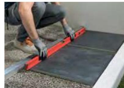
Verificare la planarità della posa ottenuta. Aggiungere ghiaia tra le fughe per livellare la pavimentazione. E' possibile utilizzare anche ghiaia decorativa di diametro superiore rispetto a quella posata sul sottofondo.
