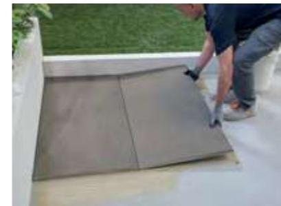
Posizionare le lastre e battere leggermente con la mazzetta di gomma per permettere la fuoriuscita dell'aria e garantire perfetta aderenza. Inserire nelle fughe i distanziatori di 4/5 mm.
