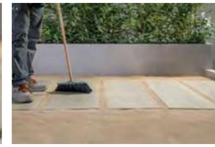
Ajouter du sable dans les joints pour niveler le sol. Nettoyer la surface des dalles.
