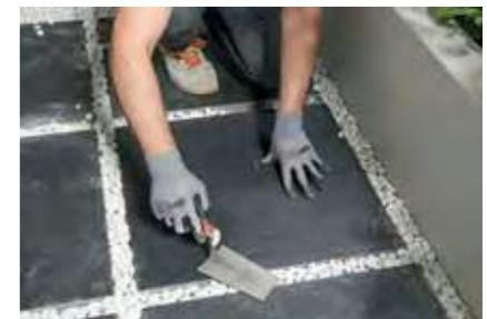
Contrôler la planéité de la pose réalisée. Ajouter du gravier dans les joints pour niveler le sol. Il est également possible d'utiliser du gravier décoratif de diamètre supérieur à celui posé sur le fond.
