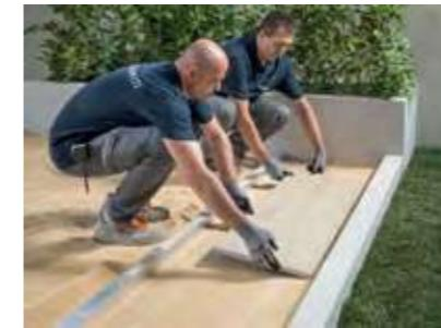
Posizionare le lastre a secco sulla sabbia e verificare che la distanza tra l'una e l'altra sia regolare per tutta la superficie di posa. Battere leggermente con la mazzetta di gomma per stabilizzare la posa.
