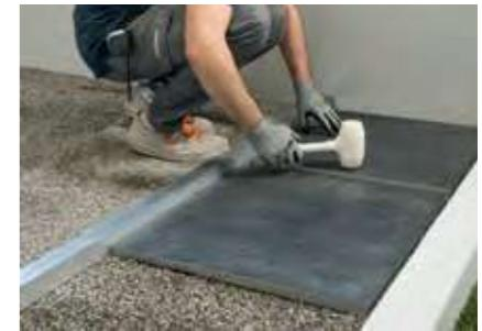
Poser les dalles à sec sur le gravier et s'assurer que la distance les séparant est régulière sur toute la surface de pose. Battre légèrement à l'aide d'un maillet en caoutchouc pour stabiliser la pose et pour éliminer les éventuelles irrégularités.
