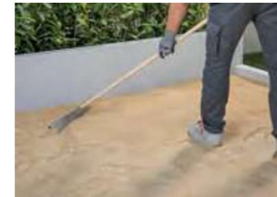
Preparare uno strato di sabbia di almeno 5 cm di spessore sul sottostante esistente (massetto o superficie ghiaiosa). Livellare la superficie con la staggia e verificarne la planarità.
