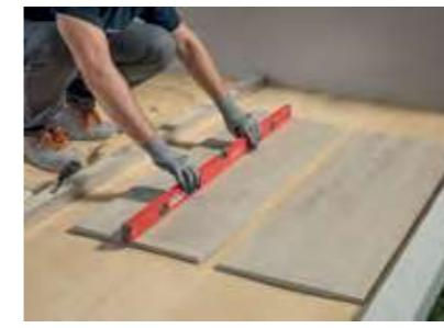
Aggiungere sabbia tra le fughe per livellare la pavimentazione. Pulire la superficie delle lastre.
