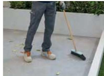
Pulire la superficie esistente e verificare la planarità del massetto per identificare il giusto supporto da utilizzare. Il massetto deve essere asciutto e stagionato. Preparare i supporti selezionati, tagliando a misura i supporti perimetrali ed eliminando le alette superflue.
