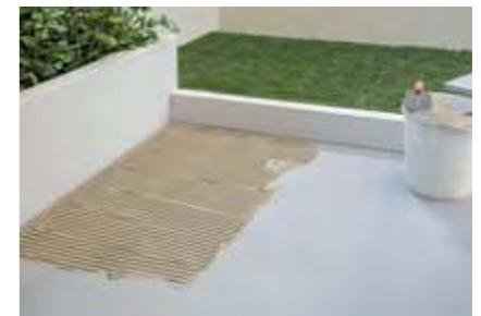
Nettoyer la surface existante et s'assurer que la chape est réalisée dans les règles de l'art : parfaitement plate et sèche. Étaler la colle de manière homogène sur la surface.
