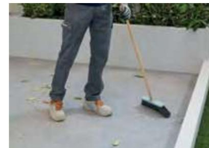
Pulire la superficie esistente e verificare che il massetto sia eseguito ad opera d'arte: planare, asciutto, stagionato. Stendere la colla adesiva in maniera omogenea sulla superficie.
