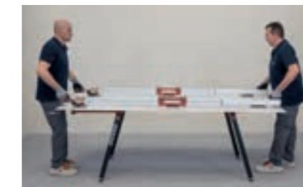
IT 3. Sollevare delicatamente la lastra e appoggiarla sul banco di lavoro, oppure ruotarla in posizione verticale e collocarla sul carrello di movimentazione per la stesura della colla.
