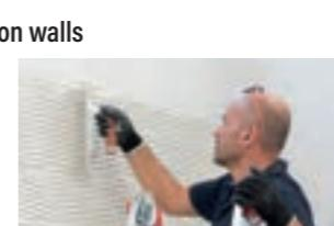
IT 2. Distribuire la colla sulla parete utilizzando l'apposita spatola a denti inclinati (10x10 mm), stendere il collante superando di 5/10 cm la superficie della lastra.
