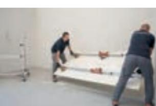
IT 5. Mediante il telaio di movimentazione con ventose di sicurezza accompagnare la lastra in posizione e posarla.
