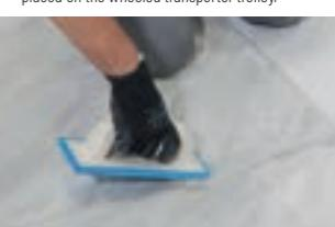
IT 8. Si raccomanda di alternare e orientare i pezzi in modo da creare una distribuzione naturale del disegno e delle venature. Si consiglia una stuccatura in tinta con il prodotto, mantenendo una fuga minima di 2 mm (come prevede la normativa europea).
