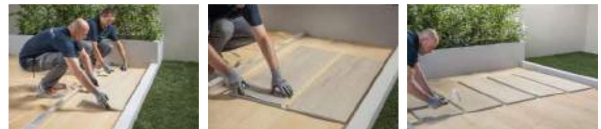
Posizionare le lastre a secco sulla sabbia e verificare che la distanza tra l'una e l'altra sia regolare per tutta la superficie di posa. Battere leggermente con la mazzetta di gomma per stabilizzare la posa.
