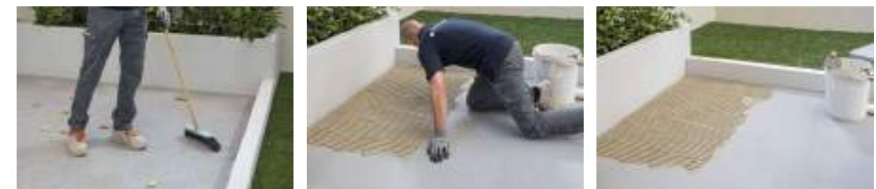
**Pulire la superficie esistente e verificare che il massetto sia eseguito ad opera d'arte: planare, asciutto, stagionato. Stendere la colla adesiva in maniera omogenea sulla superficie.**
