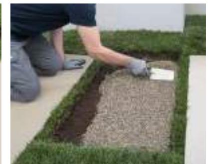
**Tracciare la porzione di terreno da asportare e realizzare uno scavo di profondità minima di 5 cm. Creare uno strato di ghiaia (diam. 3/6 mm) di almeno 3 cm.**
