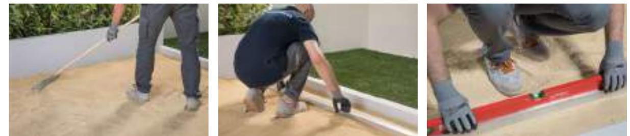
Preparare uno strato di sabbia di almeno 5 cm di spessore sul sottofondo esistente (massetto o superficie ghiaiosa). Livellare la superficie con la staggia e verificarne la planarità.
