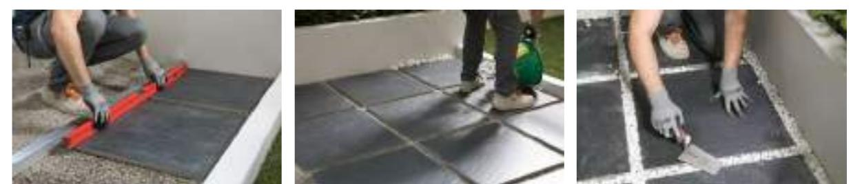
Verificare la planarità della posa ottenuta. Aggiungere ghiaia tra le fughe per livellare la pavimentazione. E' possibile utilizzare anche ghiaia decorativa di diametro superiore rispetto a quella posata sul il sottofondo.
