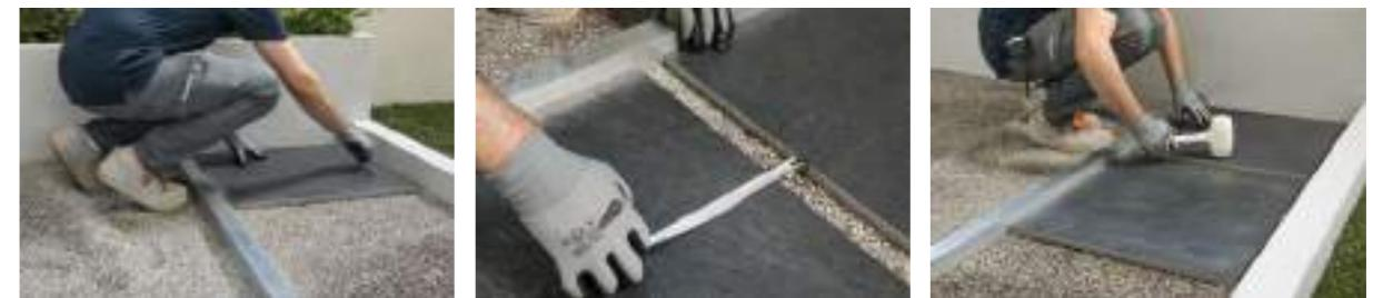
Posizionare le lastre a secco sulla ghiaia e che la distanza tra l'una e l'altra sia regolare per tutta la superficie di posa. Battere leggermente con la mazzetta di gomma per stabilizzare la posa ed eliminare eventuali irregolarità.
