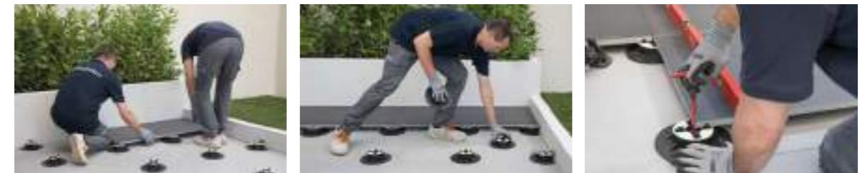
**Posizionare a secco le lastre sui supporti. Aggiungere un supporto al centro della lastra, eliminando le alette distanziatrici. Verificare sistematicamente la planarità e regolare le altezze dei supporti con l'apposita chiave di regolazione per compensare eventuali irregolarità del sottofondo. Si suggerisce di prevedere idonee ed opportune pendenze al fine di ridurre il rischio di ristagni d'acqua.**
