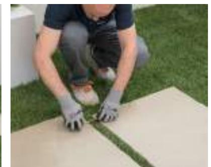
**Posizionare le lastre a secco sull'erba e verificare che la distanza tra l'una e l'altra sia regolare per tutta la superficie di posa.**
