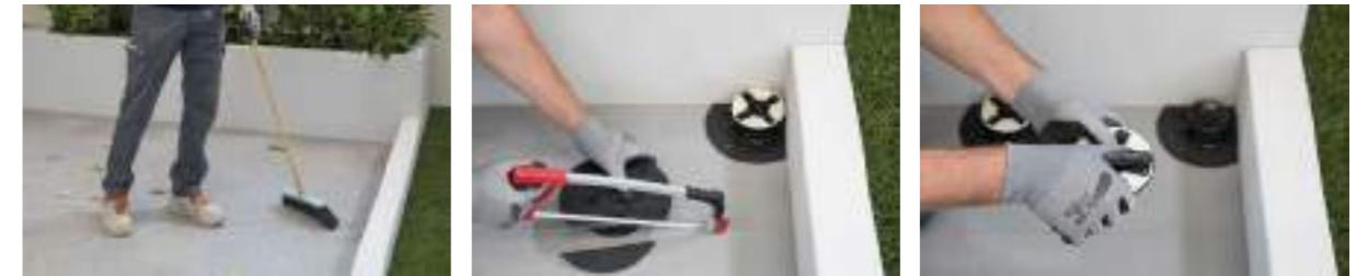
**Pulire la superficie esistente e verificare la planarità del massetto per identificare il giusto supporto da utilizzare. Il massetto deve essere asciutto e stagionato. Preparare i supporti selezionati, tagliando a misura i supporti perimetrali ed eliminando le alette superflue.**
