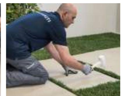
**Dopo aver verificato la planarità del fondo realizzato, posizionare le lastre e battere leggermente con la mazzetta di gomma per stabilizzare la posa ed eliminare eventuali irregolarità.**
