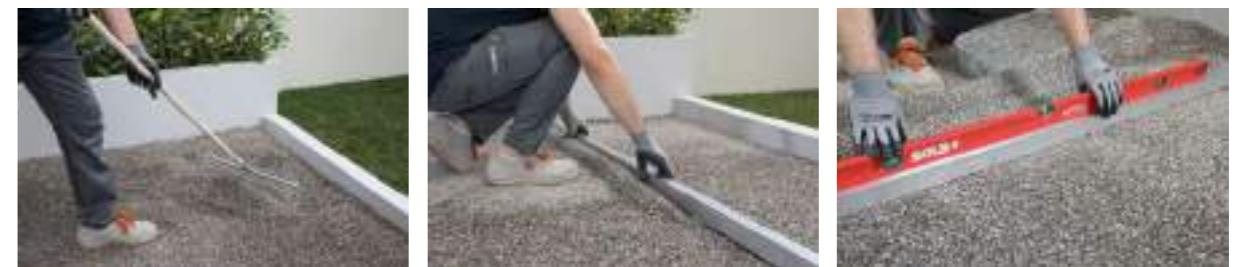
Preparare sul sottofondo esistente uno strato di ghiaia (diam. 3/6 mm) di almeno 5 cm di spessore. Livellare la superficie con la staggia e verificarne la planarità.
