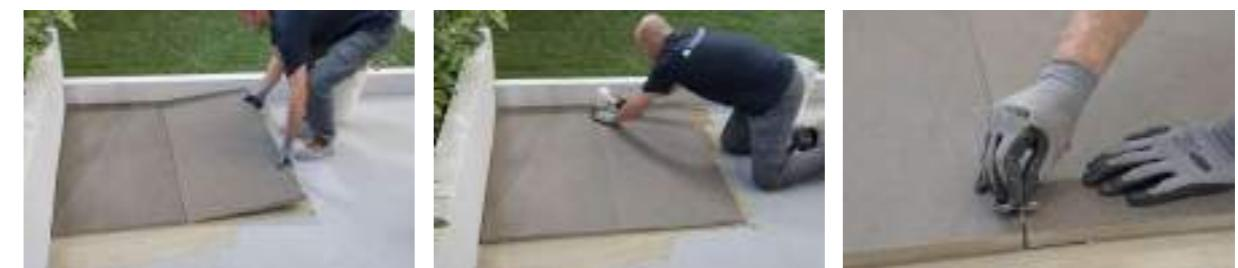
**Posizionare le lastre e battere leggermente con la mazzetta di gomma per permettere la fuoriuscita dell'aria e garantire perfetta aderenza. Inserire nelle fughe i distanziatori di 4/5 mm.**
