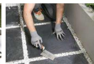
Comprobar la planicidad de la superficie colocada. Rellenar con gravilla las juntas para nivelar el pavimento. También es posible utilizar gravilla decorativa de mayor diámetro que la utilizada para el soporte.
