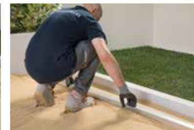
Eine mindestens 5 cm dicke Sandschicht auf dem vorhandenen Untergrund (Estrich oder kieshaltiger Boden) vorbereiten. Die Oberfläche mit einem Streichbrett ebenen und anschließend die Ebenheit überprüfen.
