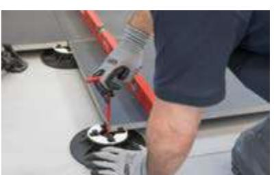
Colocar las baldosas en seco sobre los soportes. Añadir un soporte en el centro de la baldosa eliminando las aletas distanciatrices. Comprobar sistemáticamente la planicidad y regular la altura de cada soporte con la llave especial de regulación para compensar eventuales irregularidades del soporte. Recomendamos verificar y adecuar el nivel de la superficie para evitar el riesgo de estancamiento de agua.
