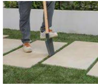
**Tracciare la porzione di terreno da asportare e realizzare uno scavo di profondità minima di 5 cm. Creare uno strato di ghiaia (diam. 3/6 mm) di almeno 3 cm.**
