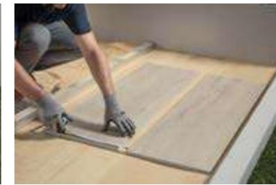
Die Platten trocken auf dem Sand positionieren und prüfen, dass der Abstand von einer zur anderen Platte entlang der gesamten Verlegungsfläche gleich ist. Die Platten leicht mit dem Gummihammer abklopfen, um die Verlegung zu stabilisieren.
