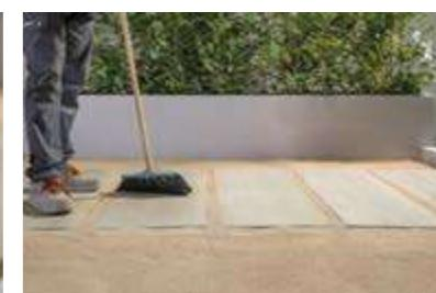
Rellenar con arena las juntas para nivelar el pavimento. Limpie la superficie de las baldosas.
