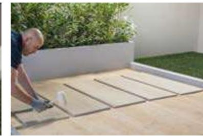
Colocar las baldosas en seco sobre la arena y comprobar que la distancia entre sí sea regular en toda la superficie colocada. Golpear la ligeramente las baldosas con la maza de goma para estabilizar la colocación.
