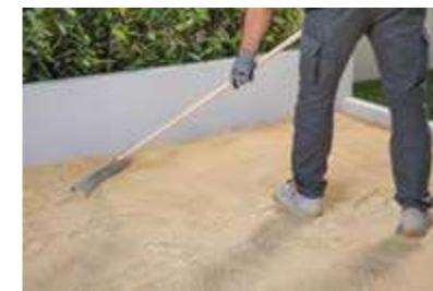
**Preparare uno strato di sabbia di almeno 5 cm di spessore sul sottofondo esistente (massetto o superficie ghiaiosa). Livellare la superficie con la staggia e verificarne la planarità.**
