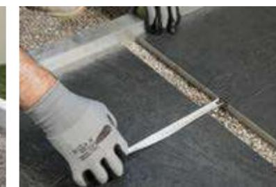
Die Platten trocken auf dem Kies positionieren und prüfen, dass der Abstand von einer zur anderen Platte entlang der gesamten Verlegungsfläche gleich ist. Die Platten mit einem Gummihammer leicht abklopfen, um die Verlegung zu stabilisieren und eventuelle Unregelmäßigkeiten auszugleichen.
