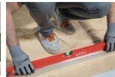
Preparar una capa de arena de al menos 5 cm de grosor sobre el soporte existente (solera o superficie de grava). Nivelar la superficie con el regle y comprobar su planicidad.
