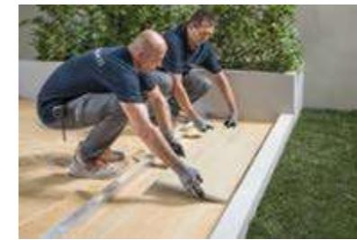
**Posizionare le lastre a secco sulla sabbia e verificare che la distanza tra l'una e l'altra sia regolare per tutta la superficie di posa. Battere leggermente con la mazzetta di gomma per stabilizzare la posa.**
