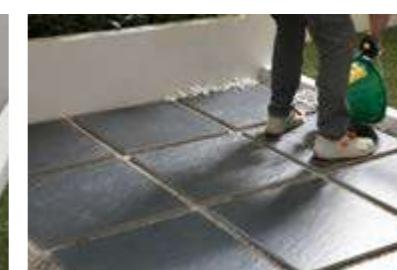
Die Ebenheit der gefertigten Verlegung überprüfen. Kies zwischen den Fugen hinzufügen, um den Bodenbelag zu nivellieren. Dazu kann auch Dekorationskies mit einem größeren Durchmesser als der Durchmesser des für die Verlegung auf dem Untergrund verwendeten Kieses benutzt werden.
