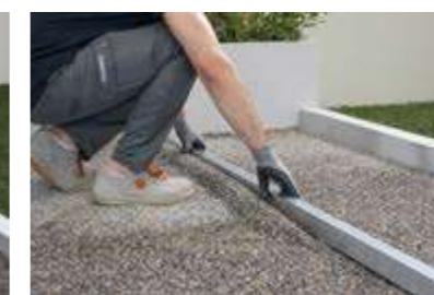
Auf dem vorhandenen Untergrund eine mindestens 5 cm dicke Kiesschicht (Durchm. 3/6 mm) vorbereiten. Die Oberfläche mit einem Streichbrett ebenen und anschließend die Ebenheit überprüfen.
