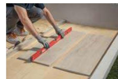
**Aggiungere sabbia tra le fughe per livellare la pavimentazione. Pulire la superficie delle lastre.**
