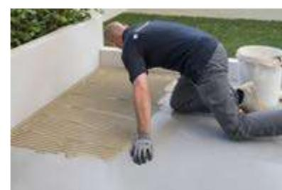
Die vorhandene Oberfläche säubern und überprüfen, dass der Estrich fachgerecht gefertigt ist: Er muss eben, trocken und belegreif sein. Den Kleber gleichmäßig auf der Oberfläche ausbreiten.
