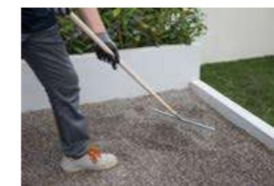
**Preparare sul sottofondo esistente uno strato di ghiaia (diam. 3/6 mm) di almeno 5 cm di spessore. Livellare la superficie con la staggia e verificarne la planarità.**
