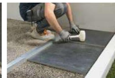
Colocar las baldosas en seco sobre la gravilla y comprobar que la distancia entre sí sea regular en toda la superficie colocada. Golpear la ligeramente las baldosas con la maza de goma para estabilizar la colocación y eliminar eventuales irregularidades.
