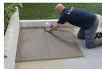
Die Platten aufsetzen und leicht mit einem Gummihammer abklopfen, damit unter den Platten vorhandene Luft austreten kann und ein perfektes Anhaften gewährleistet ist. 4/5 mm breit Abstandhalter in den Fugen einsetzen.
