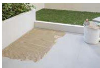
Limpiar la superficie existente y comprobar que la solera esté perfectamente realizada: planicidad, seco y fraguado. Extender el adhesivo de forma homogénea sobre la superficie.
