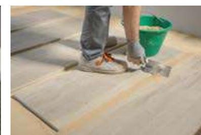
Sand zwischen den Fugen hinzufügen, um den Bodenbelag zu nivellieren. Die Oberfläche der Platten reinigen.
