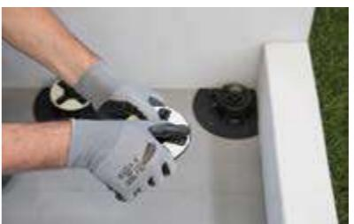
Limpie la superficie existente y comprobar la planicidad de la solera para elegir el soporte más adecuado que se debe utilizar. La solera debe estar seca y haber completado su fraguado. Preparar los soportes seleccionados, cortando a medida los soportes perimetrales y eliminando las aletas sobrantes.
