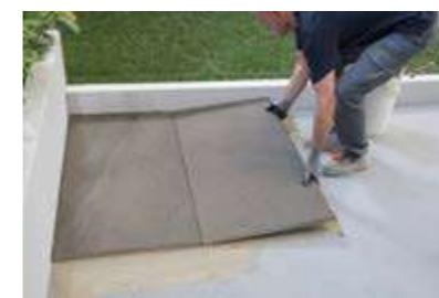
**Posizionare le lastre e battere leggermente con la mazzetta di gomma per permettere la fuoriuscita dell'aria e garantire perfetta aderenza. Inserire nelle fughe i distanziatori di 4/5 mm.**
