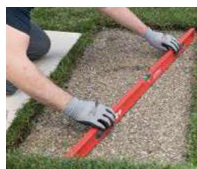
**Dopo aver verificato la planarità del fondo realizzato, posizionare le lastre e battere leggermente con la mazzetta di gomma per stabilizzare la posa ed eliminare eventuali irregolarità.**
