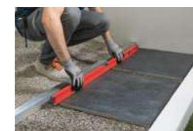
**Verificare la planarità della posa ottenuta. Aggiungere ghiaia tra le fughe per livellare la pavimentazione. È possibile utilizzare anche ghiaia decorativa di diametro superiore rispetto a quella posata sul il sottofondo.**
