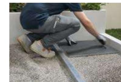
**Posizionare le lastre a secco sulla ghiaia e che la distanza tra l'una e l'altra sia regolare per tutta la superficie di posa. Battere leggermente con la mazzetta di gomma per stabilizzare la posa ed eliminare eventuali irregolarità.**
