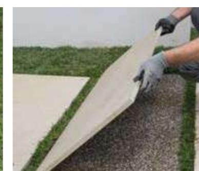
Die Ebenheit des gefertigten Untergrundes überprüfen, danach die Platten positionieren und leicht mit dem Gummihammer abklopfen, um die Verlegung zu stabilisieren und eventuelle Unregelmäßigkeiten auszugleichen.
