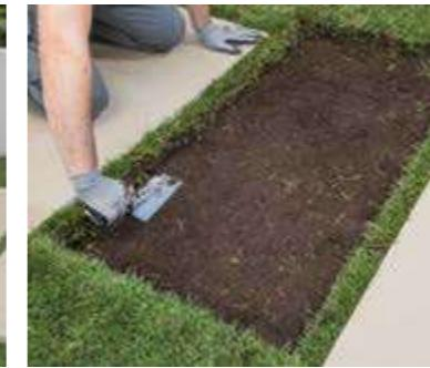
Die zu entfernende Erdbodenportion anreißen und eine mindestens 5 cm tiefe Ausgrabung fertigen. Eine mindestens 3 cm dicke Kiesschicht (Durchm. 3/6 mm) bilden.
