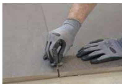
Colocar las baldosas y golpear ligeramente con la maza de goma para permitir que salga el aire y garantizar una adherencia perfecta. Colocar separadores de 4/5 mm en las juntas.
