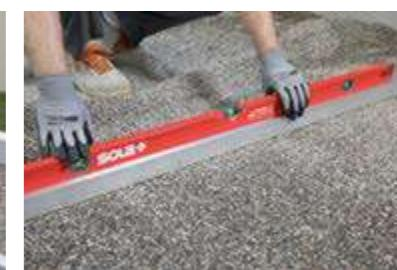
Preparar una capa de gravilla en el soporte existente (de 3/6 mm de diámetro) de 5 cm como mínimo de grosor. Nivelar la superficie con el regle y comprobar su planicidad.
