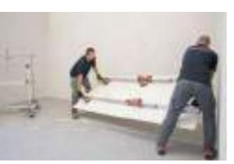
**IT 5** Mediante il telaio di movimentazione con ventose di sicurezza accompagnare la lastra in posizione e posarla.
