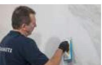
**EN 8** Si raccomanda di alternare e orientare i pezzi in modo da creare una distribuzione naturale del disegno e delle venature. Si consiglia una stuccatura in tinta con il prodotto, mantenendo una fuga minima di 2 mm (come prevede la normativa europea).
