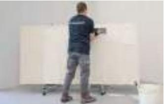
**EN 4** Stendere il collante sul retro della lastra utilizzando l'apposita spatola a denti quadrati (3x3 mm) e accertarsi che di quelle della spalmatura della lastra. Durante la fase di stesura, la lastra dovrà essere in posizione verticale e fissata al telaio di movimentazione con ventose di sicurezza posate sopra al carrello per il trasporto con ruote.
