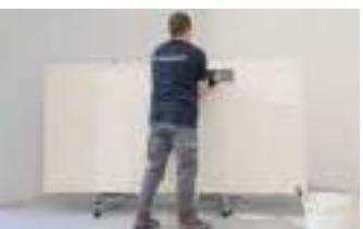
**EN 4** Stendere il collante sul retro della lastra utilizzando l'apposita spatola a denti quadrati (3x3 mm) e accertarsi che le righe dell'ultima stesura siano nella stessa direzione di quelle della spalmatura della lastra. Durante la fase di stesura, la lastra dovrà essere in posizione verticale e fissata al telaio di movimentazione con ventose di sicurezza posate sopra al carrello per il trasporto con ruote.
