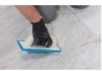
**EN 8** Si raccomanda di alternare e orientare i pezzi in modo da creare una distribuzione naturale del disegno e delle venature. Si consiglia una stuccatura in tinta con il prodotto, mantenendo una fuga minima di 2 mm (come prevede la normativa europea).
