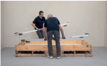
IT 1_Le lastre 160x320/120x280 cm devono obbligatoriamente essere movimentate da due persone con barre / telaio di movimentazione con ventose. EN 1_Slabs in sizes 160x320/120x280 cm must be handled by two people with the aid of suction cup handling bars / frame.
