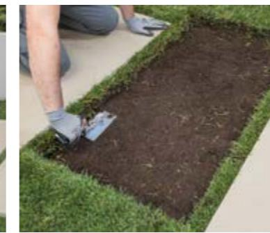
Die zu entfernde Erdbodenportion anreißen und eine mindestens 5 cm tiefe Ausgrabung fertigen. Eine mindestens 3 cm dicke Kieschicht (Durchm. 3/6 mm) bilden.
