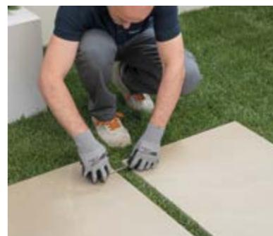
Colocar las baldosas en seco sobre la hierba y comprobar que la distancia entre sí sea regular en toda la superficie colocada.
