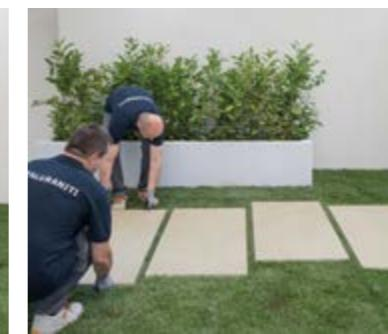
Die Platten trocken auf dem Gras positionieren und prüfen, dass der Abstand von einer zur anderen Platte entlang der gesamten Verlegungsfläche gleich ist.
