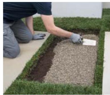
Marcar el área de terreno que se debe retirar y excavar un hueco de una profundidad mínima de 5 cm. Colocar una capa de grava (de 3/6 mm de diámetro) de 3 cm como mínimo.
