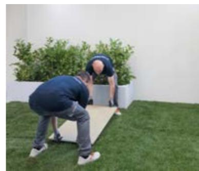
**Posizionare le lastre a secco sull'erba e verificare che la distanza tra l'una e l'altra sia regolare per tutta la superficie di posa.**
