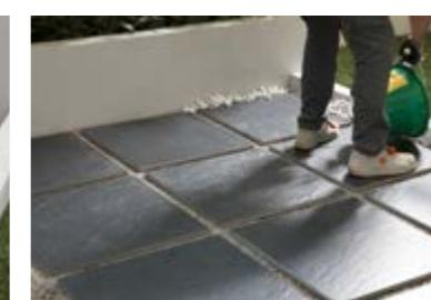
Die Ebenheit der gefertigten Verlegung überprüfen. Kies zwischen den Fugen hinzufügen, um den Bodenbelag zu nivellieren. Dazu kann auch Dekorationskies mit einem größeren Durchmesser als der Durchmesser des für die Verlegung auf dem Untergrund verwendeten Kieses benutzt werden.
