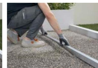
Auf dem vorhandenen Untergrund eine mindestens 5 cm dicke Kiesschicht (Durchm. 3/6 mm) vorbereiten. Die Oberfläche mit einem Streichbrett ebenen und anschließend die Ebenheit überprüfen.
