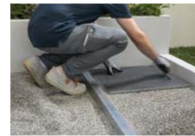
**Posizionare le lastre a secco sulla ghiaia e che la distanza tra l'una e l'altra sia regolare per tutta la superficie di posa. Battere leggermente con la mazzetta di gomma per stabilizzare la posa ed eliminare eventuali irregolarità.**
