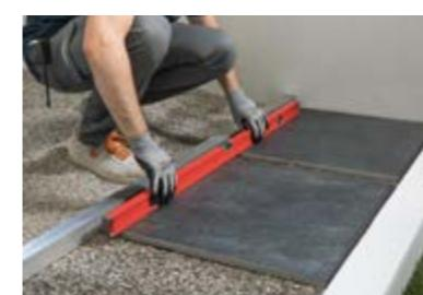
**Verificare la planarità della posa ottenuta. Aggiungere ghiaia tra le fughe per livellare la pavimentazione. E' possibile utilizzare anche ghiaia decorativa di diametro superiore rispetto a quella posata sul il sottofondo.**
