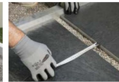
Die Platten trocken auf dem Kies positionieren und prüfen, dass der Abstand von einer zur anderen Platte entlang der gesamten Verlegungsfläche gleich ist. Die Platten mit einem Gummihammer leicht abklopfen, um die Verlegung zu stabilisieren und eventuelle Unregelmäßigkeiten auszugleichen.
