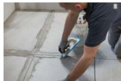
Nachdem der Kleber getrocknet ist, die Abstandhalter entfernen, die Fugen mit Fugenmörtel ausfügen und die Rückstände durch eine sorgfältige Reinigung entfernen.
