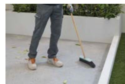
**Pulire la superficie esistente e verificare che il massetto sia eseguito ad opera d'arte: planare, asciutto, stagionato. Stendere la colla adesiva in maniera omogenea sulla superficie.**
