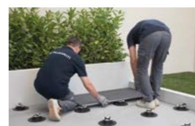
**Posizionare a secco le lastre sui supporti. Aggiungere un supporto al centro della lastra, eliminando le alette distanziatrici. Verificare sistematicamente la planarità e regolare le altezze dei supporti con l'apposita chiave di regolazione per compensare eventuali irregolarità del sottostante. Si suggerisce di prevedere idonee ed opportune pendenze al fine di ridurre il rischio di ristagni d'acqua.**
