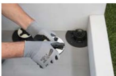
Limpiar la superficie existente y comprobar la planicidad de la solera para elegir el soporte más adecuado que se debe utilizar. La solera debe estar seca y haber completado su fraguado. Preparar los soportes seleccionados, cortando a medida los soportes perimetrales y eliminando las aletas sobrantes.
