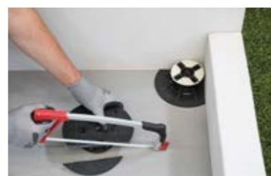
Die vorhandene Oberfläche säubern und den Estrich auf Ebenheit prüfen, um zu bestimmen, welche Stützen verwendet werden müssen. Der Estrich muss trocken und belegfrei sein. Die gewählten Stützen vorbereiten, die Randstützen auf das richtige Maß zuschneiden und die überflüssigen Teile entfernen.
