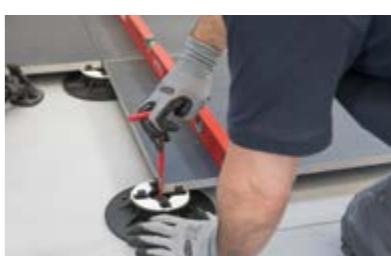
Colocar las baldosas en seco sobre los soportes. Añadir un soporte en el centro de la baldosa eliminando las aletas distanciatrices. Comprobar sistemáticamente la planicidad y regular la altura de cada soporte con la llave especial de regulación para compensar eventuales irregularidades del soporte. Recomendamos verificar y adecuar el nivel de la superficie para evitar el riesgo de estancamiento de agua.
