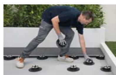
Die Platten trocken auf den Stützen positionieren. Eine Stütze an der Plattenmitte hinzufügen und die Abstandshalteflügel beseitigen. Die Ebenheit systematisch überprüfen und die Höhen der Stützen mit dem entsprechenden Einstellschlüssel regeln, um eventuelle Unregelmäßigkeiten des Untergrundes auszugleichen. Bitte das entsprechende Gefälle berücksichtigen um Stauässer zu vermeiden.
