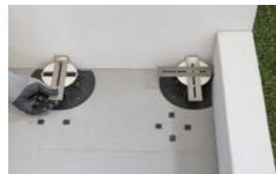
Das Stützenschema auf dem Verlegungsuntergrund anbringen und dabei mit den Randstützen beginnen. Die Schutzklammern der Fliesenränder auf alle Stützen setzen, die mit Wänden in Berührung stehen.
