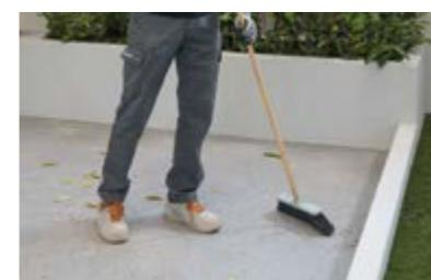
**Pulire la superficie esistente e verificare la planarità del massetto per identificare il giusto supporto da utilizzare. Il massetto deve essere asciutto e stagionato.**
