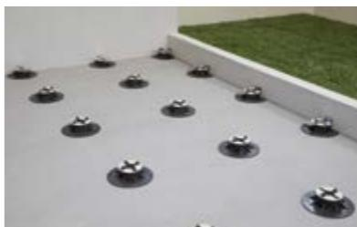
Colocar la retícula de soportes siguiendo el diseño de colocación, empezando por los perimetrales. Colocar los clips de protección de borde de baldosa en los soportes que están en contacto con la pared.
