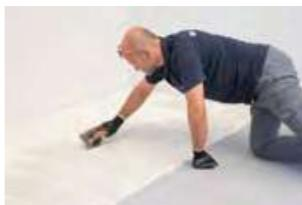
IT 2. Distribuire la colla sul pavimento utilizzando l'apposita spatola a denti inclinati (10x10 mm), stendere il collante superando di 5/10 cm la superficie della lastra.
