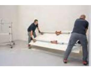
IT 5. Mediante il telaio di movimentazione con ventose di sicurezza accompagnare la lastra in posizione e posarla.
