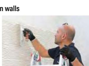
IT 2. Distribuire la colla sulla parete utilizzando l'apposita spatola a denti inclinati (10x10 mm), stendere il collante superando di 5/10 cm la superficie della lastra.
