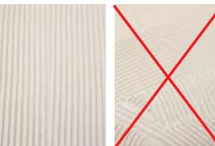
IT 3. Una volta distribuito il collante accertarsi che nell'ultima stesura l'andamento delle righe sia sempre e solo in un unico verso (per una stesura a regola d'arte le righe dovrebbero essere in linea con il lato corto della lastra), evitare gli incroci che non favoriscono l'espulsione dell'aria dal centro della lastra.
