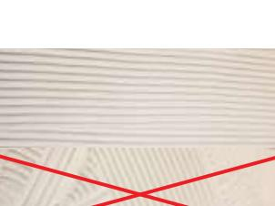
IT 3. Una volta distribuito il collante accertarsi che nell'ultima stesura l'andamento delle righe sia sempre e solo in un unico verso (per una stesura a regola d'arte le righe dovrebbero essere in linea con il lato corto della lastra), evitare gli incroci che non favoriscono l'espulsione dell'aria dal centro della lastra.
