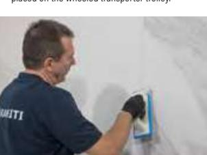
IT 8. Si raccomanda di alternare e orientare i pezzi in modo da creare una distribuzione naturale del disegno e delle venature. Si consiglia una stuccatura in tinta con il prodotto, mantenendo una fuga minima di 2 mm (come prevede la normativa europea).
