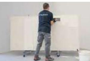
IT 4. Stendere il collante sul retro della lastra utilizzando l'apposita spatola a denti quadrati (3x3 mm) e accertarsi che le righe dell'ultima stesura siano nella stessa direzione di quelle della spalmatura della lastra. Durante la fase di stesura, la lastra dovrà essere in posizione verticale e fissata al telaio di movimentazione con ventose di sicurezza posate sopra al carrello per il trasporto con ruote.
