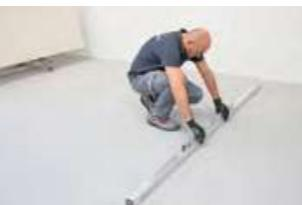
IT 1. Prima di procedere con la posa verificare che il fondo sia perfettamente planare, asciutto e pulito. Utilizzare i collanti descritti miscelati in base alle specifiche indicate nella scheda tecnica del collante prescelto. Si raccomanda l'utilizzo di adesivi cementizi ad alte prestazioni in classe C2 o superiore.
